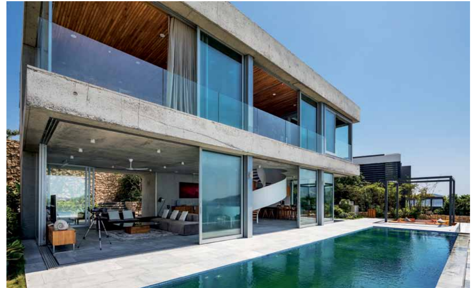
The column-free main space on the ground floor of the Stone House. Ruang utama yang bebas kolom pada lantai dasar Stone House.
